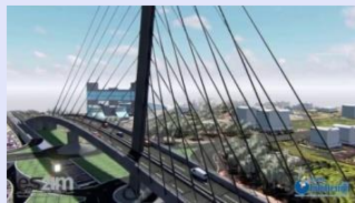
Future Pont à Haubans Sidi Maarouf
