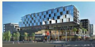
La ZAC de Metz mêle bureaux, logements et commerces sur un même îlot
